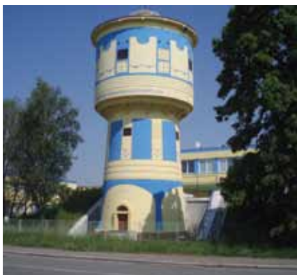
Vodojemy a úpravný pitné vody (úprava vody chlorováním)
