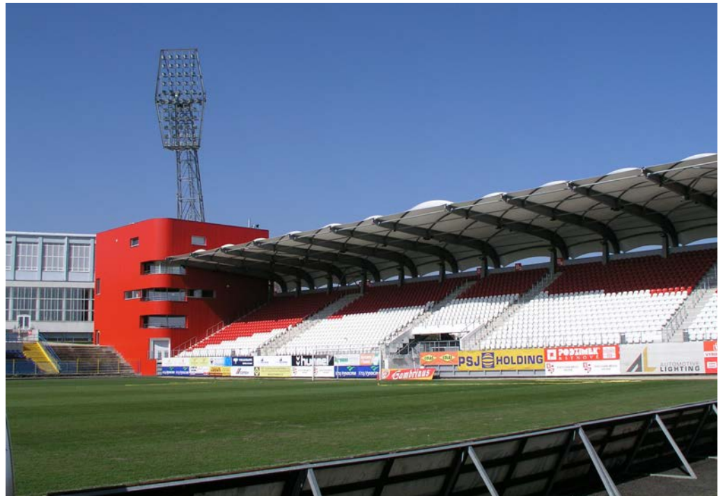
Naše reference v Jihlavě – výstavba tribun fotbalového stadionu FC Vysočina
