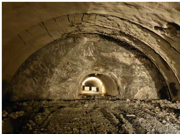
Severní tunelová roura s průzkumnou štolou
