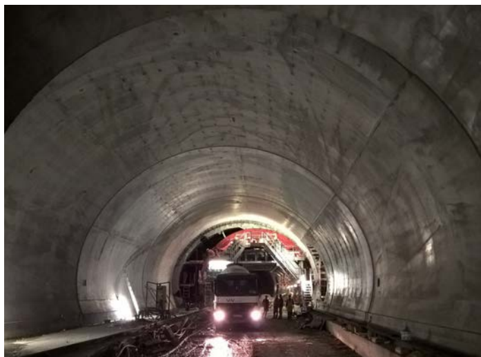
Betonáž sekundárního ostění
