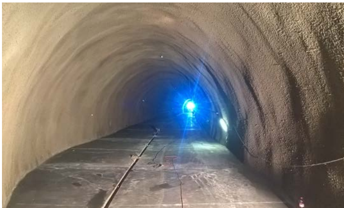
Sekundární ostění ze stříkaného vláknobetonu
