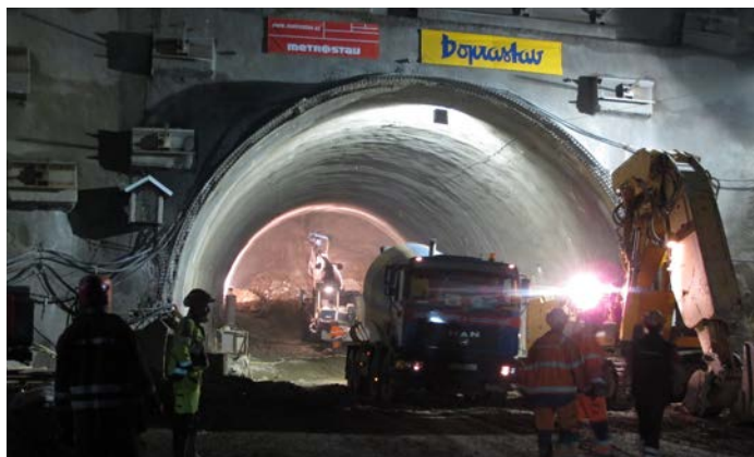
Aplikace stříkaného betonu - hlavní tunelová roura
