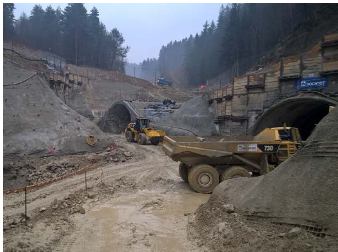
Střední stavební jáma – Považský Chlmec
