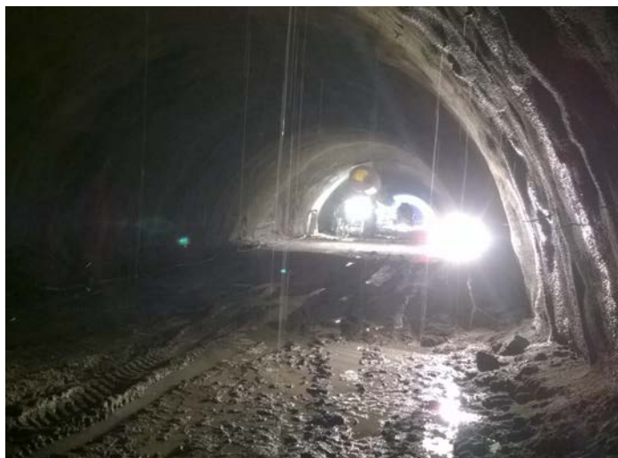
Primární tunelové ostění - jižní tunelová roura
