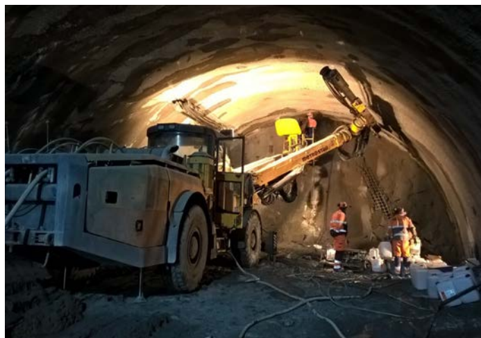
Stabilizační injektáž čelby a nadloží při ražbě
