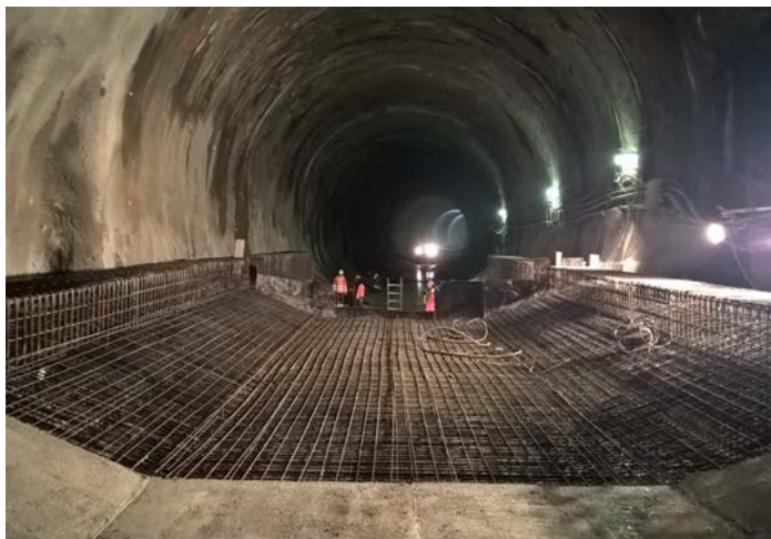
Betonáž protiklenby jižní tunelové roury
