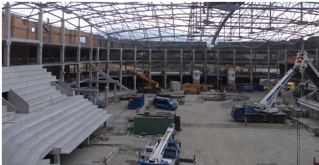
Naše reference v Třinci (CZ): WERK ARENA – atypické prvky ze samozhutitelného betonu
