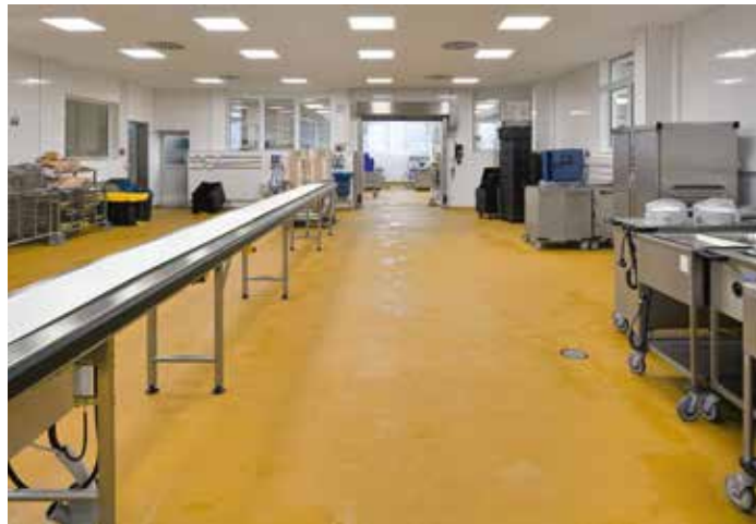
Unsere Referenz in Rüsselsheim (Deutschland): Großküche GPR Klinikum
