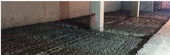
MasterEmaco PCC I-System wird als Betonersatz zur Sanierung und Instandsetzung von horizontalen Betonflächen eingesetzt und kann auch als Einbettmörtel für den kathodischen Korrosionsschutz verwendet werden. Das System entspricht den Anforderungen nach ZTV-ING, Teil 3, Abschnitt 4 und der Beanspruchbarkeitsklasse M2/M3 nach Rili SIB der DAfStb-Richtlinie.
