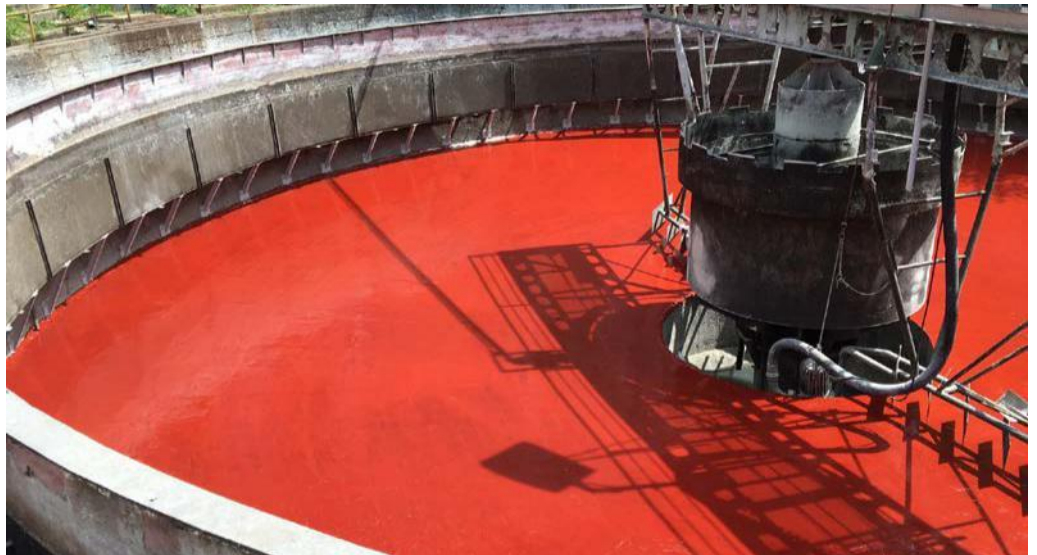
Sanierung und Abdichtung des Tanks
