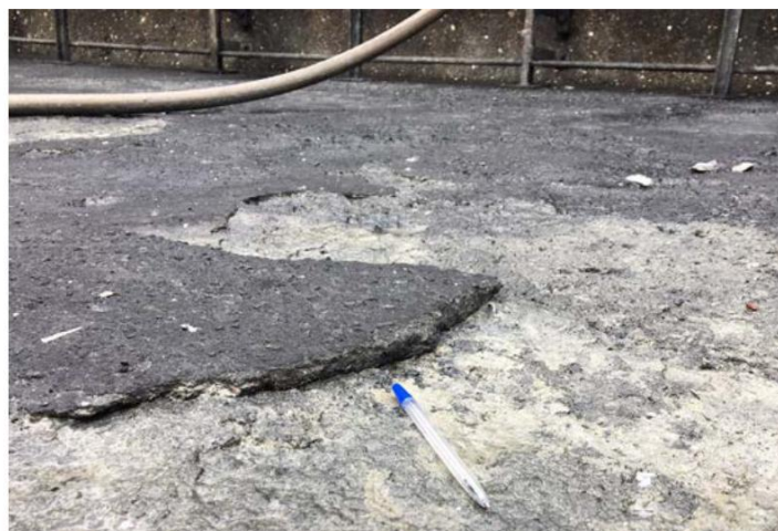
Sanierung und Abdichtung des Tanks
