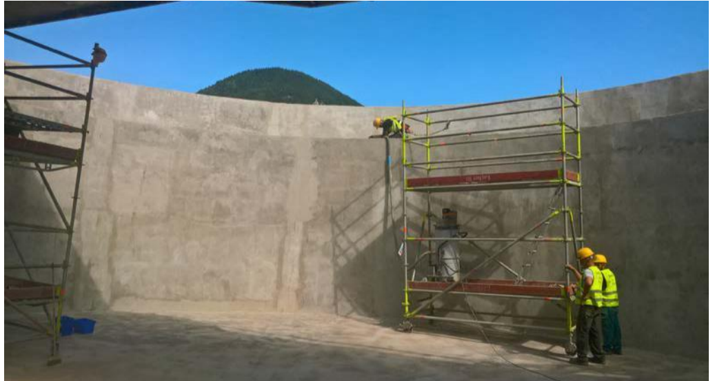
Sanierung und Abdichtung eines Tanks
