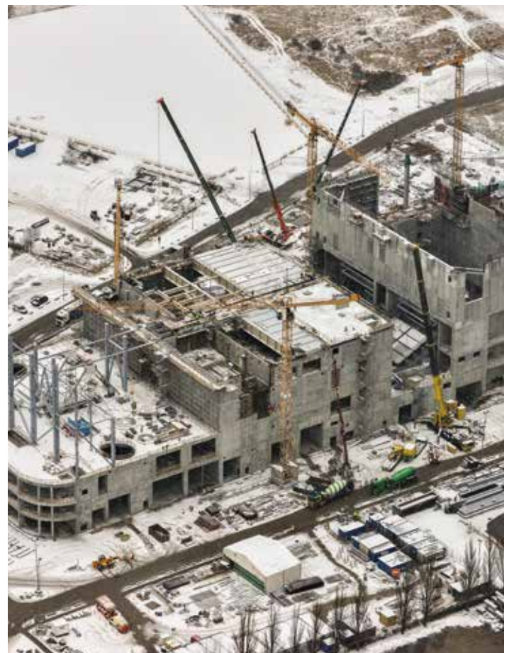
Master X-Seed half beim Bau der Müllverwertungsanlage Amager Bakke in Kopenhagen, Dänemark. Auf dem Dach der Anlage befindet sich eine öffentlich zugängliche künstliche Skipiste.
