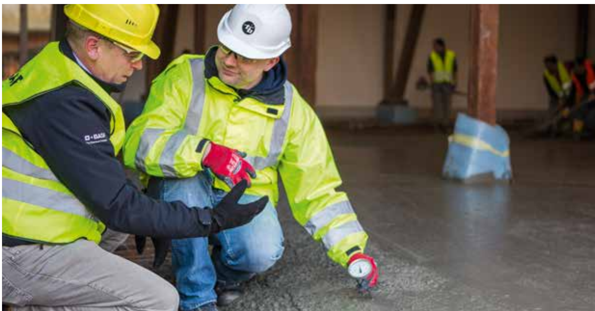
Mit Master X-Seed können sich Betonhersteller den speziellen Anforderungen des Betonierens im Winter anpassen.
