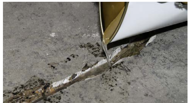
Vergießen von MasterInject 1360 in einen V-förmig geöffneten Bodenriss
