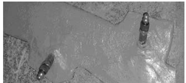
Bohrpacker korrekt verteilt auf beiden Seiten eines Risses und mit MasterBrace ADH 3000 oberflächendicht verspachtelt.
