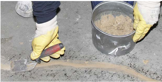
Abspachteln eines mit sandgefülltem MasterInject 1360 vergossenen Risses
