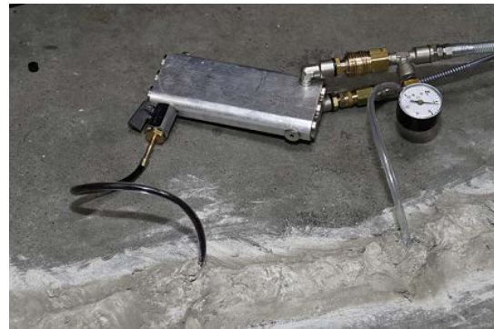
Rissverpressung von MasterInject 1380 mit einer 2K Niederdruckmaschine zum kraftschlüssigen Schließen eines Bodenrisses
