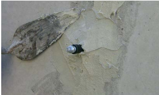
Abdichten eines Klebepackers mit MasterFlow 920 AN
