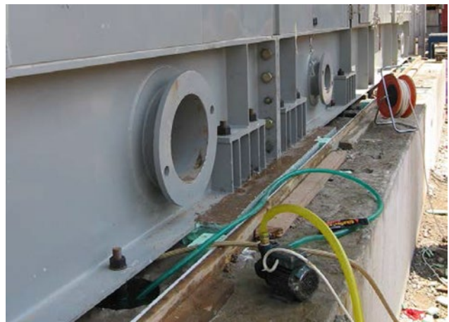
Vornässen und Entfernen überschüssigen Wassers in Verankerungslöchern eines Turbinenfundaments vor dem Vergießen
