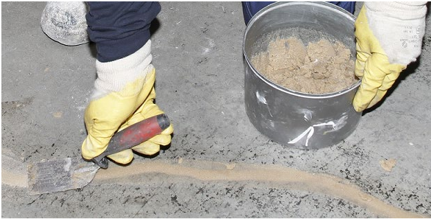
Abspachteln eines mit sandgefülltem MasterInject 1360 vergossenen Risses
