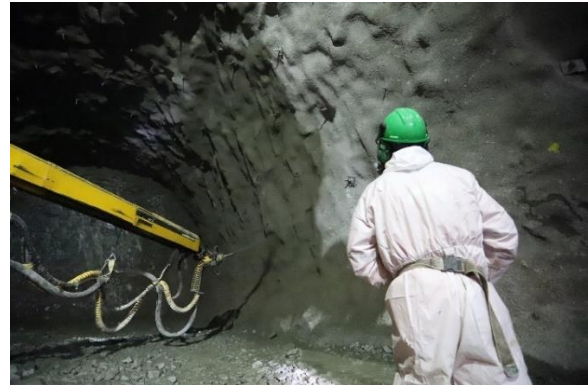
Chile: Túnel El Melón II
