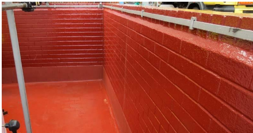
Приямок для сбора аварийных проливов
