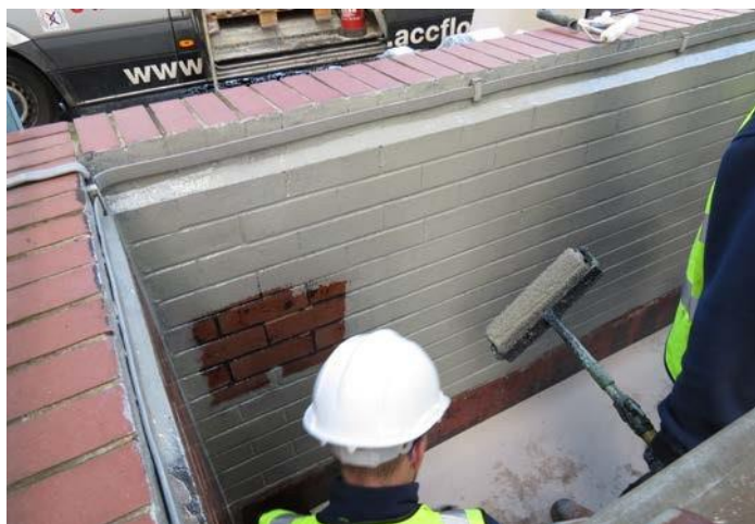
Приямок для сбора аварийных проливов
