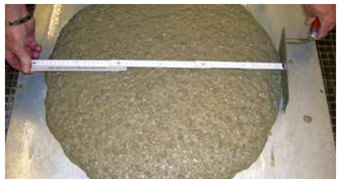
Pruebas de calidad de concreto proyectado
