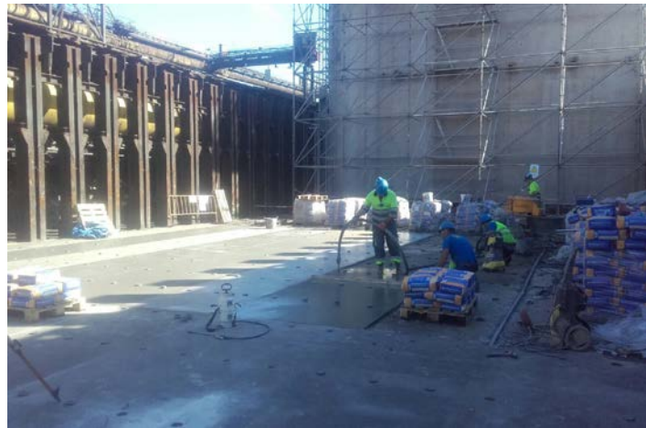
Aplicación de mortero fluido MasterEmaco S 5450 PG aditivado con fibra MasterFiber 400 por bombeo sin presión.
