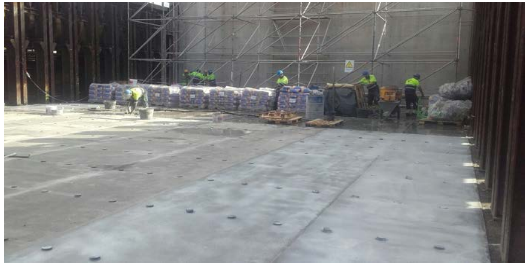
Reparación y refuerzo de forjados de hormigón exteriores en ARCELOR (Gijón).
