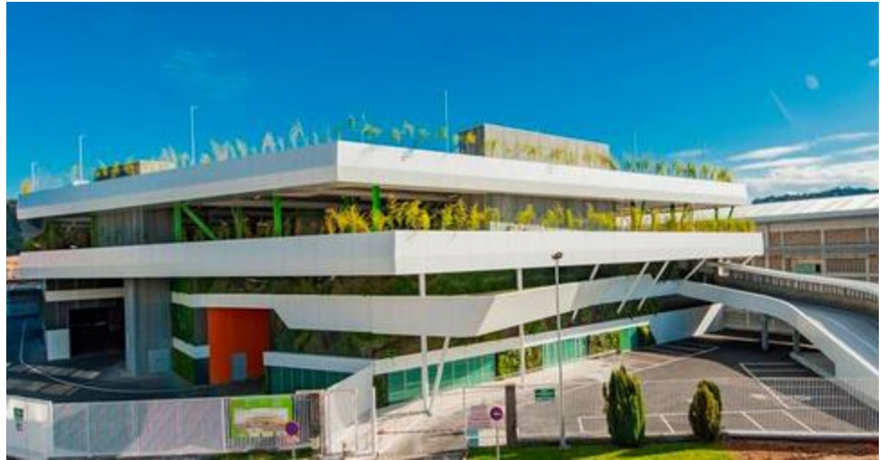
Cubierta parking MasterSeal Traffic 2201 en instalaciones de Citroën en Vigo.
