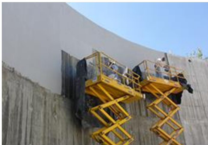
Detalle de las medias cañas con MasterEmaco S 5400 y de las distintas capas: imprimación MasterSeal P 621, y membrana MasterSeal M 336
