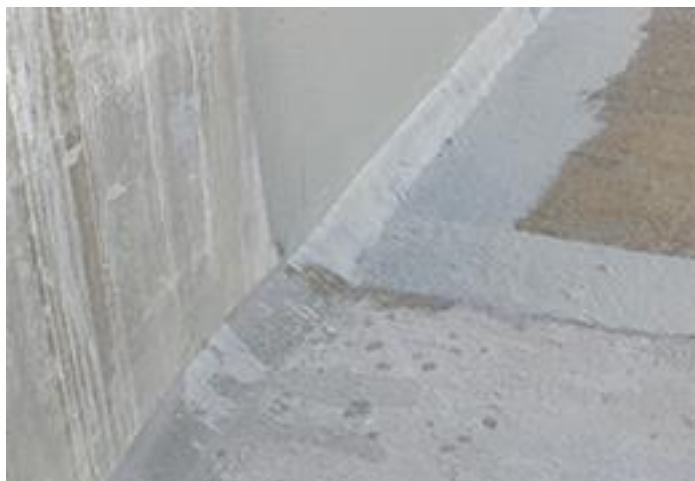
Detalle de las medias cañas con MasterEmaco S 5400 y de las distintas capas: imprimación MasterSeal P 621, y membrana MasterSeal M 336
