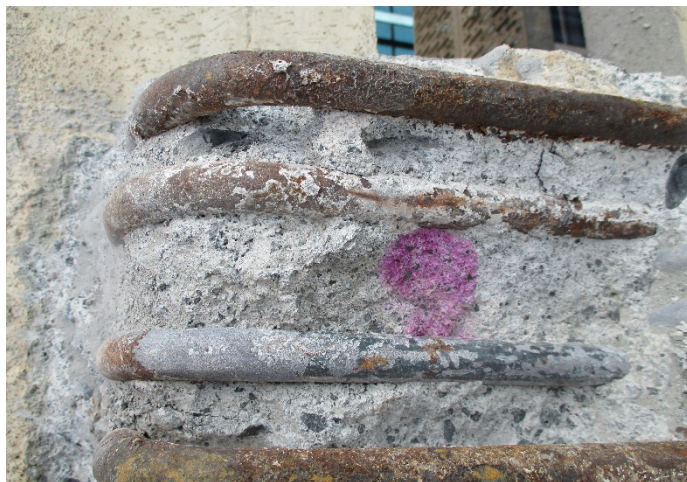
Estado previo de los elementos de hormigón armado de la fachada.
