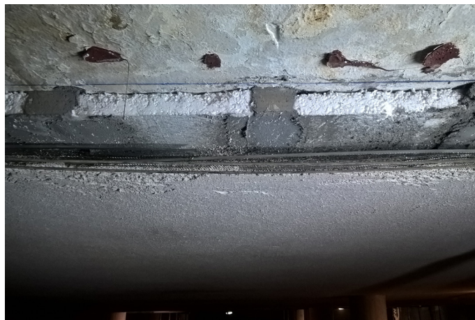
Vista de viga reconstruida con mortero
