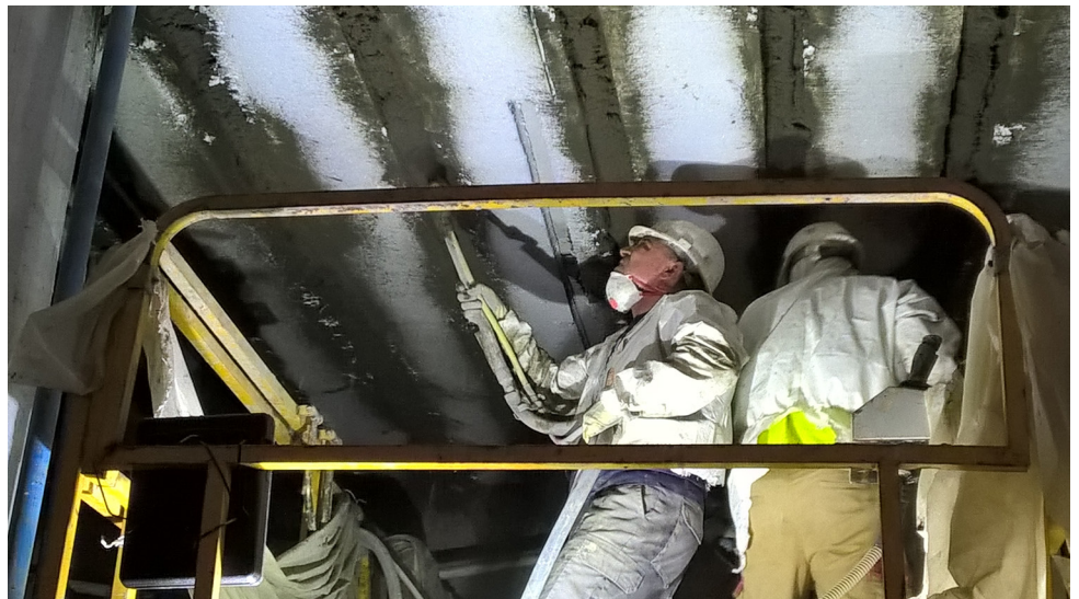
Reparación de viguetas mediante mortero MasterEmaco
