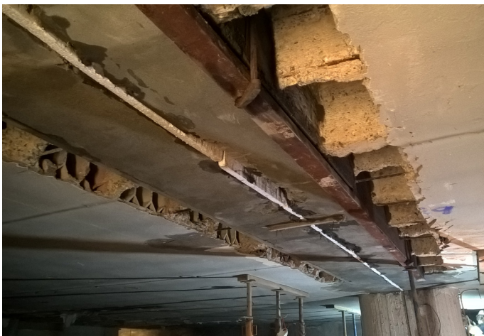
Preparación y saneo previo del soporte de hormigón armado
