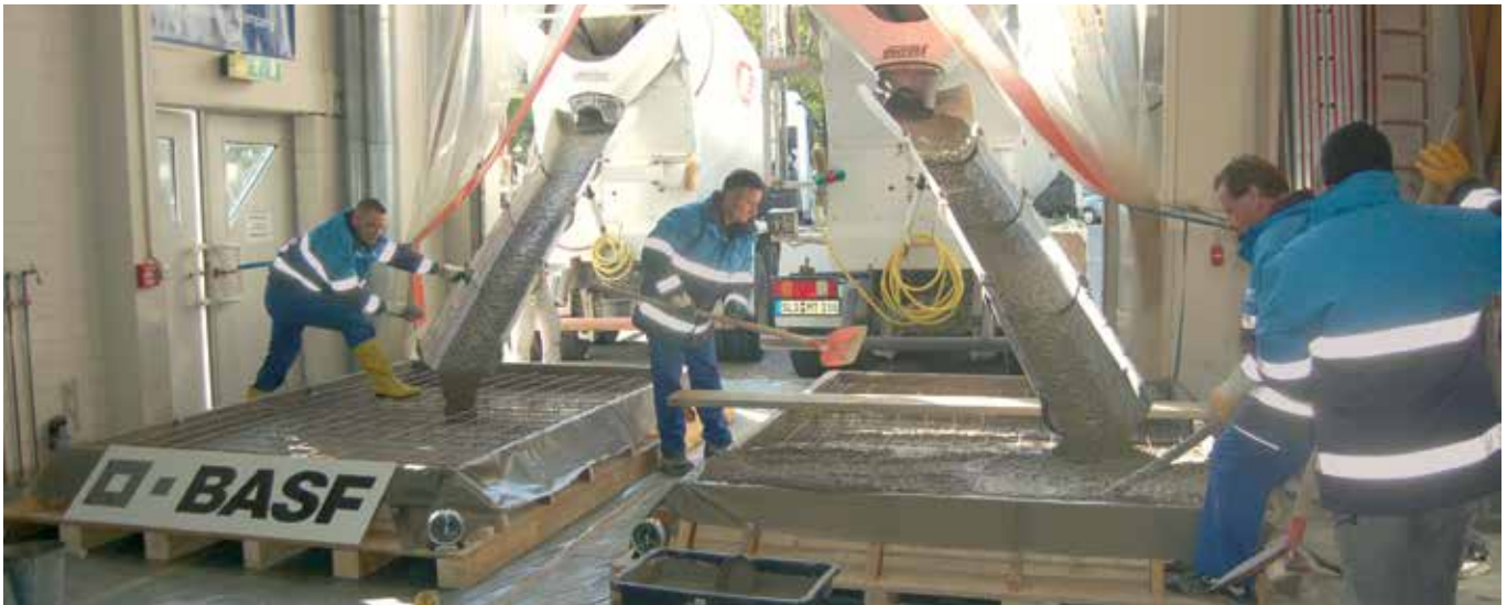
Yksi käyttäjä voi levittää Smart Dynamic Concrete -betonin selvästi nopeammin kuin 3 käyttäjää levittää perinteisen tärytettävän betonin.
