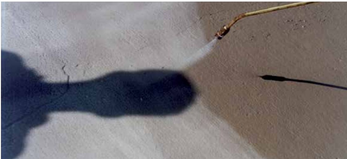
MasterKuren levitys betonin pinnalle rakennustyömaalla.
