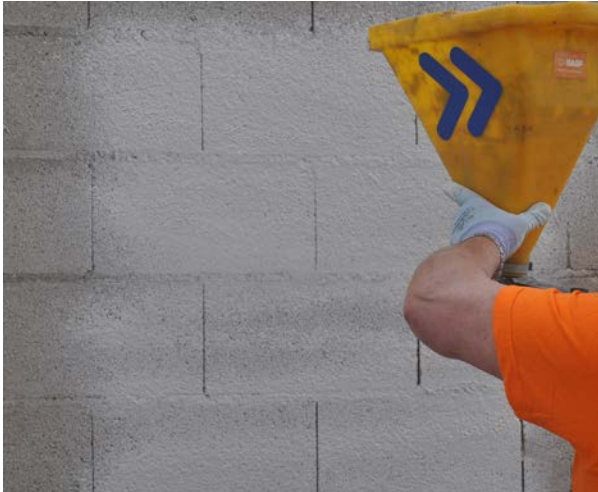
Kuva 2: MasterSeal 560:n levitys ruiskuttamalla
