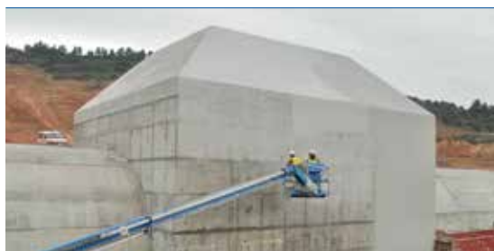
Presa Albagés (Lleida - Espanja)
