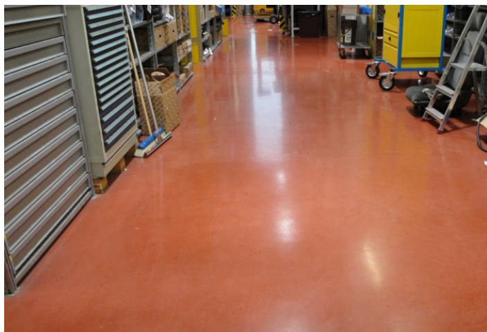
Valmis huoltokorjaamon lattia, Oy Scan Auto Ab
