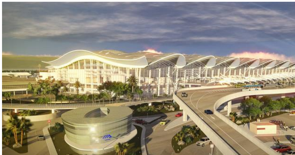
Dar El Beïda, Alger, Algérie : Nouveau Aéroport d'Alger
