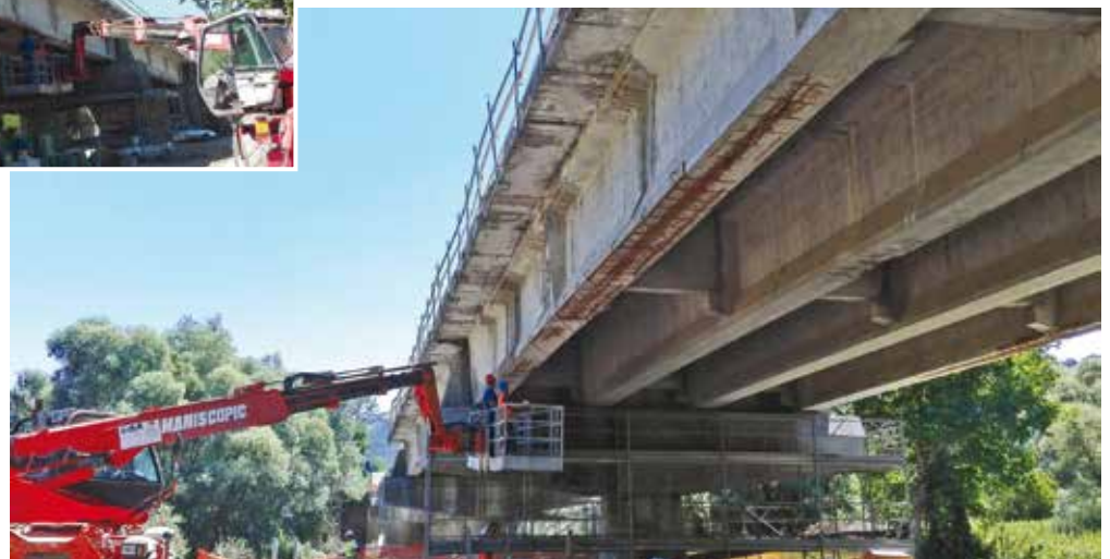
4A e 4B. La trave di bordo del viadotto Piana del Cerro
