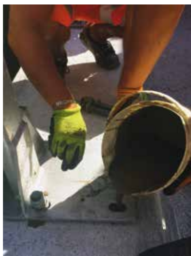
10. L'applicazione del Masterflow 960 per l'ancoraggio delle barriere
