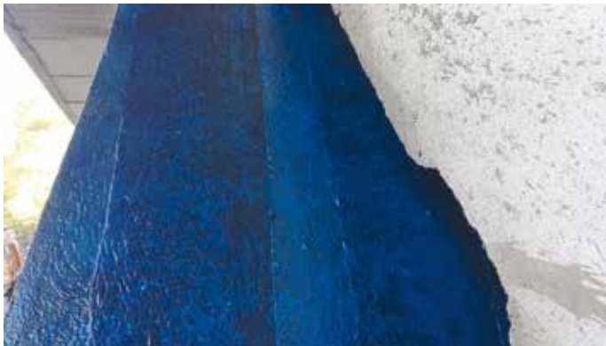
8. L'impregnazione del tessuto MasterBrace FIB CFH
