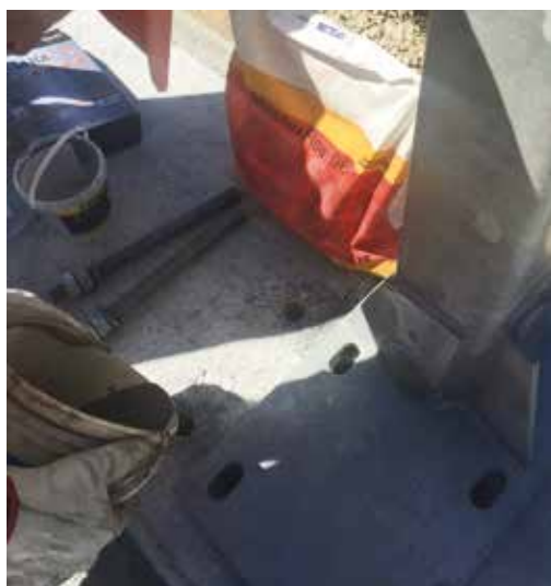
11. Il colaggio del Masterflow 960
