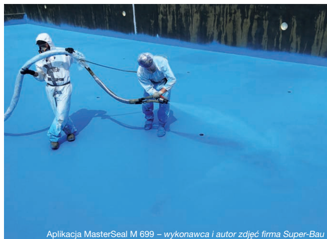
Aplikacja MasterSeal M 699 – wykonawca i autor zdjęć firma Super-Bau
