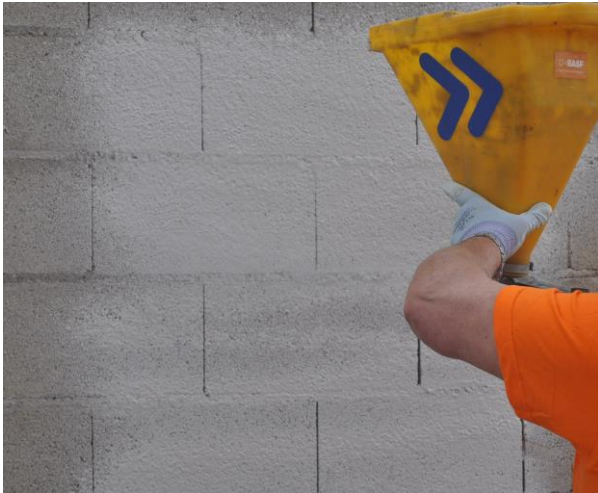
Rys. 2: Nanoszenie natryskowe MasterSeal 560
