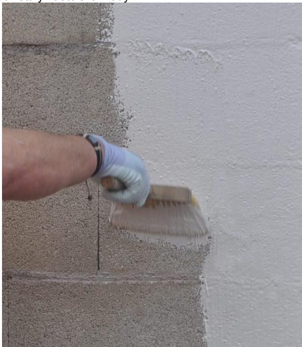
Rys. 1: Nakładanie pędzlem
