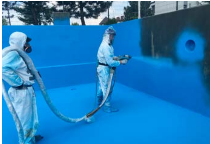
Natrysk membrany MasterSeal M 699
