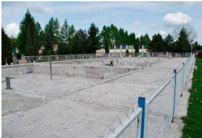
Widok basenu podczas skuwania płytek
