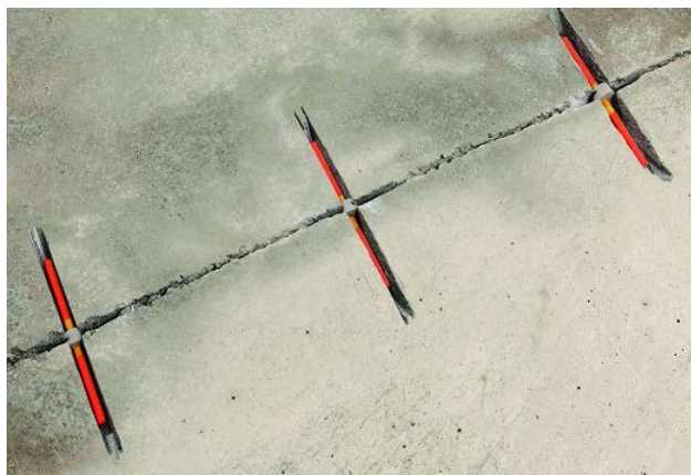
Figura 3. Montarea ancorelor metalice in canalele taiate pe fisura.
