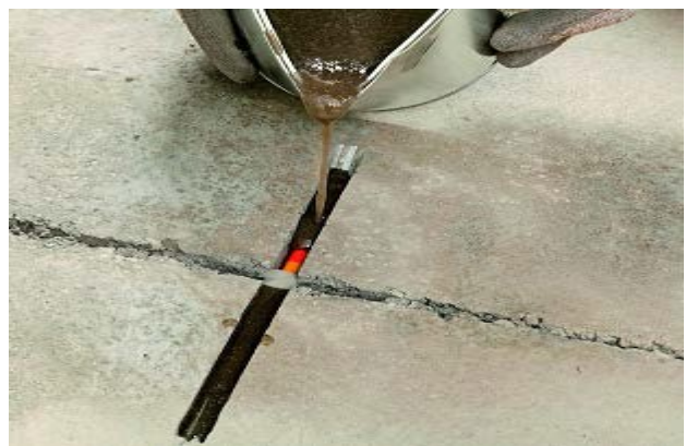
Figura 6. Umplerea canalelor de fixare a ancorelor metalice cu amestec de MasterInject 1360 si nisip cuarzos uscat
