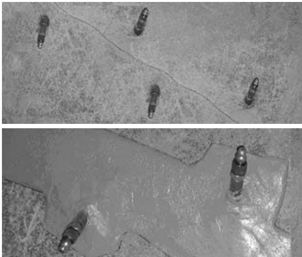
Figura 1. Packere plasate in jurul fisurii si sigilate cu adeziv epoxidic din gama MasterBrace
