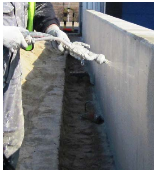
Imaginea 2: Aplicarea prin pulverizare a MasterSeal 6100 FX
