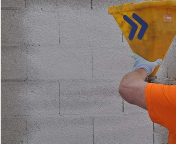
Imaginea 2: Aplicare prin pulverizare a MasterSeal 560
