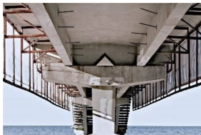
Через 15 лет после проведения ремонтных работ
