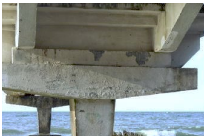
Через 10 лет после проведения ремонтных работ
