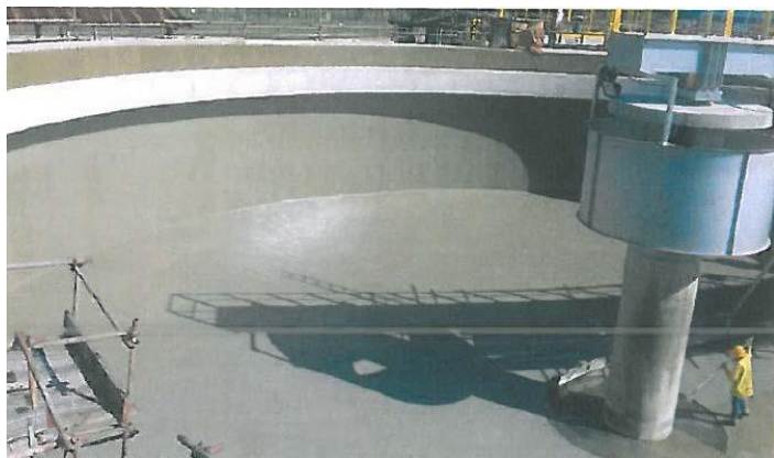
Нанесение MasterSeal 7000 CR на поверхности резервуара-отстойника
