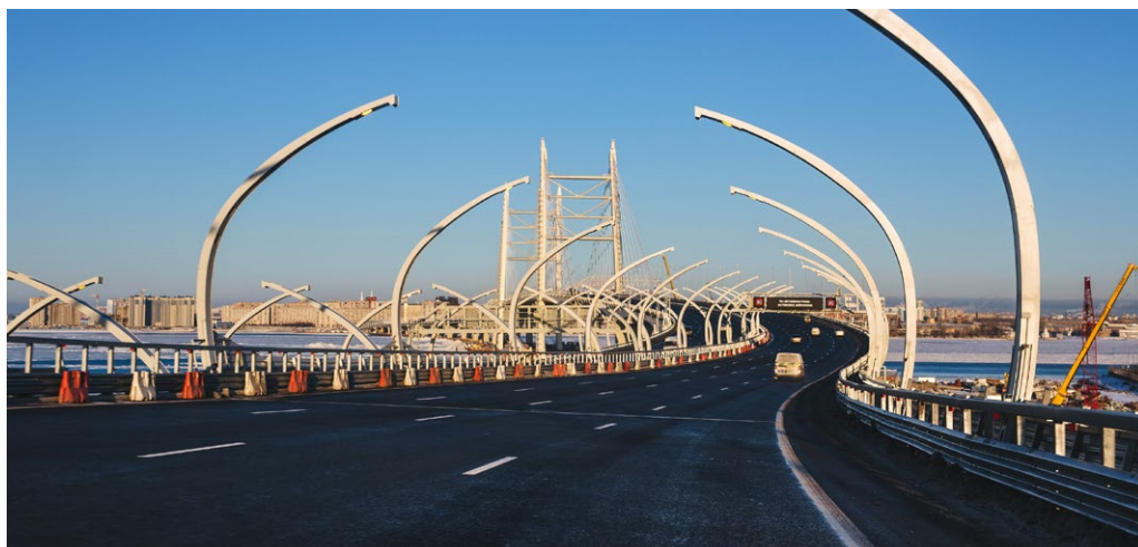
Объект: Западный скоростной диаметр, г. Санкт-Петербург
