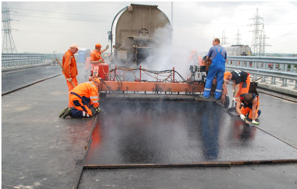
Объект мост-эстакада через реку Чаченку
