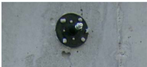
Рисунок 1. Размещение устанавливаемого на поверхности ниппеля по центру отверстия трещины.
