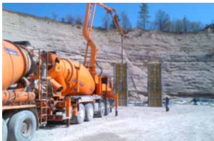
Obr. 4: Zkoušky čerpatelnosti betonu s přísadami PCE a PAE
