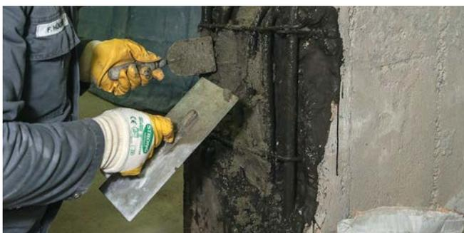
Reprofilierung mit Reparaturmörtel MasterEmaco S 551
