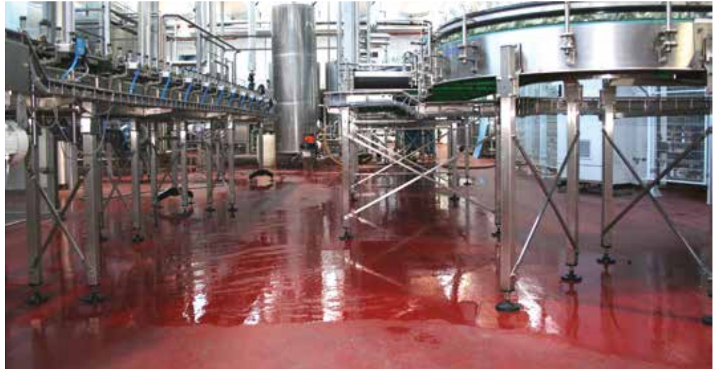
Unsere Referenz in Kitzingen (Deutschland): Abfüllanlage der Winzergemeinschaft Franken eG
