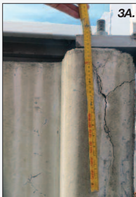
3A e 3B. Un classico inghisaggio di tirafondi con problemi di sfilamento e/o rottura del supporto (3A) e relativo schema (3B)
