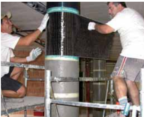
6.3.1 Confinamento pilastro in cemento armato
