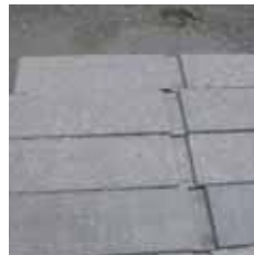
6.1.7 Negli interventi di placcaggio la sabbiatura è indispensabile
