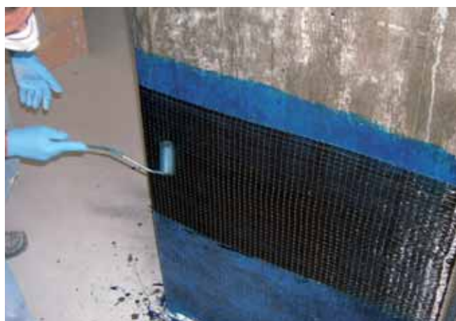
6.3.3 Schemi di rinforzo per confinamento con tessuto FRP
