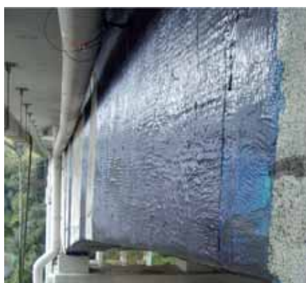
6.2.1 Fasciature MasterBrace ad U per il rinforzo al taglio
