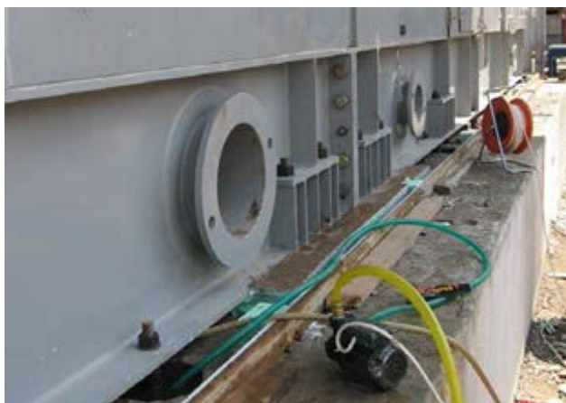
Obr. 1. Saturácia a odstránenie prebytočnej vody z kotviacich otvorov základov turbíny pred zalievaním.
