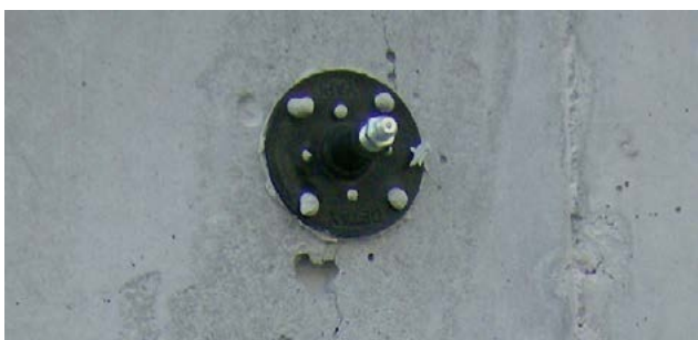
Obr 1. Umiestnenie injektážneho pakra lepeného na povrch trhliny
