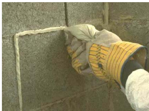
Obr. 2: Aplikácia pomocou plastového vrečka
